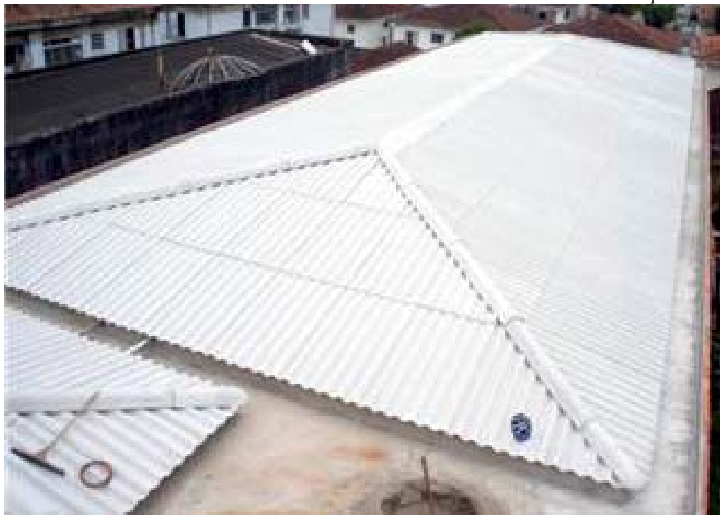
Com o telhado pronto, o sistema hidráulico é o próximo item do cronograma
